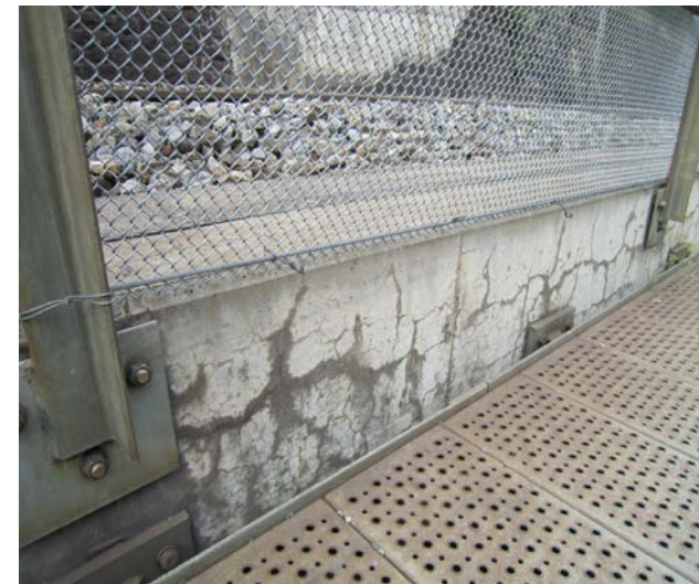
Konsolkopf einer Brückenplatte
