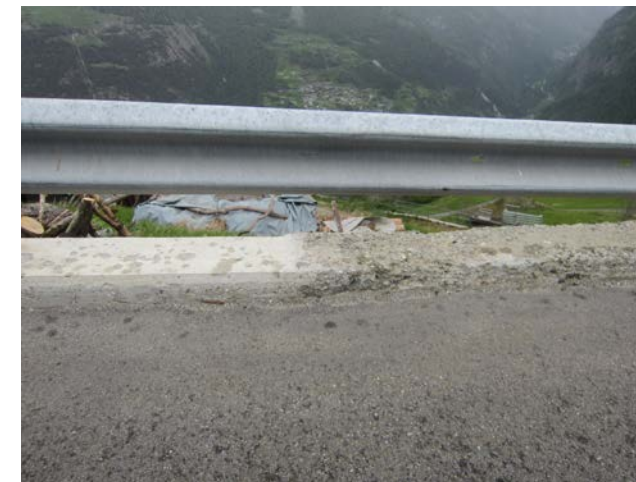
Konsolkopf einer Stützmauer
