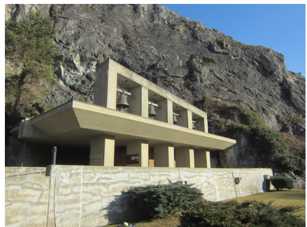
Abb. 4-1 Felsenkirche Raron, Aussenansicht mit Stützmauer (Vordergrund) und Glockenjoch
