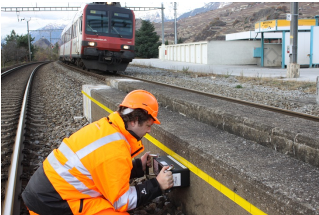
Abb. 2-5 Ultraschall-Tomografie bei einer AKR-geschädigten Eisenbahnbrücke
