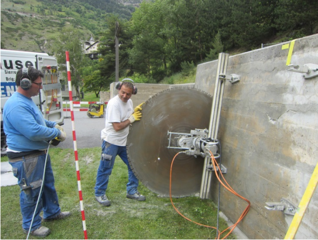
Abb. 4-3 Einsatz der schienengeführten Wandsäge (Nassschnittverfahren)
