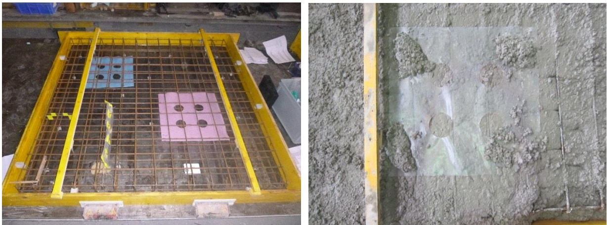
Abb. 5 Prüfkörper C vor dem Betonieren mit den eingelegten (hellblau und pink) Dämmmatten (links) sowie die während dem Betoniervorgang eingelegte PE-Folie (rechts)
