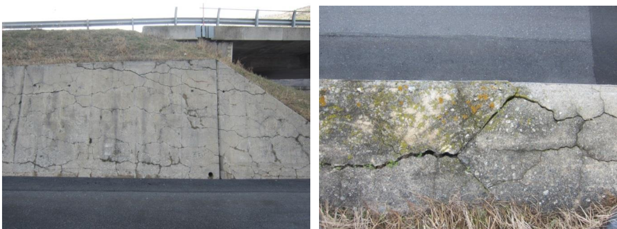
Abb. 2. Beispiel einer AKR-geschädigten Stützmauer, Ansicht (links) und Detail Mauerkrone mit Rissbild (rechts)
