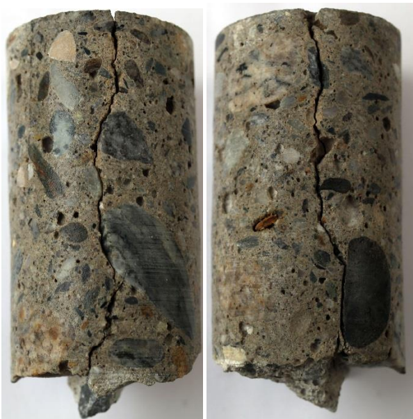
Abb. 2-3 Bohrkern d=50 mm aus der Bodenplatte
