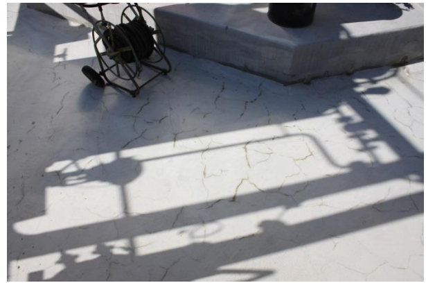
Abb. 5-2 Rissbild Bodenplatte
