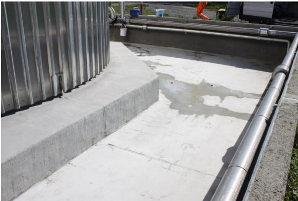
Abb. 5-1 Bodenplatte und Sockel des Tanklagers
