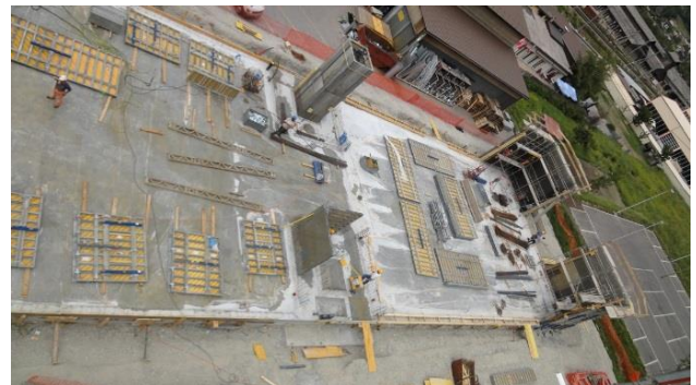
Abb. 2-1 Draufsicht auf die in zwei Etappen ausgeführte Bodenplatte
