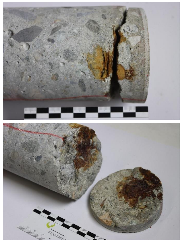
Abb. 6: Schalenbildung im Bereich korrodierender Bewehrung
