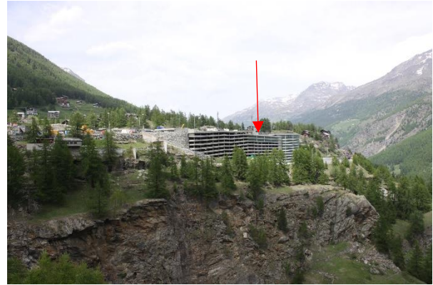
Abb. 8: Die beiden Parkhäuser P3 (Vordergrund) und P5 (Pfeilmarkierung) in Saas Fee
